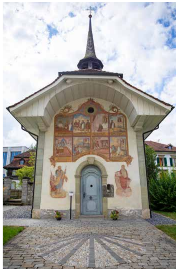
Die Jakobskapelle in Tifers befindet sich direkt neben der Pfarrkirche.
